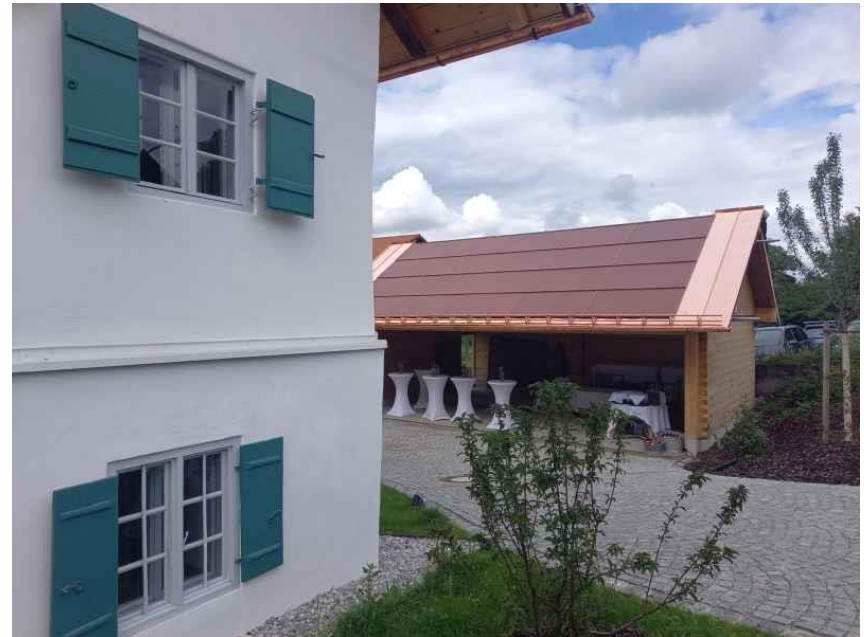
Ohlstadt (Lkr. Garmisch- Partenkirchen), integrierte Anlage auf Nebengebäude, Denkmalnähe
