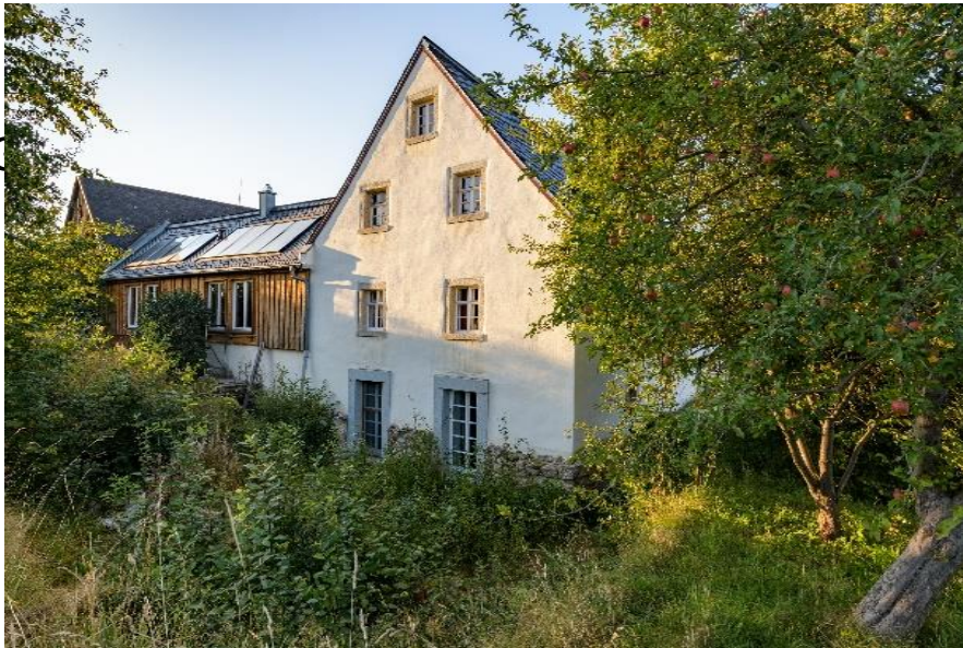
Braunersgrün (Landkreis Wunsiedel), Solarthermieanlage, Denkmal
