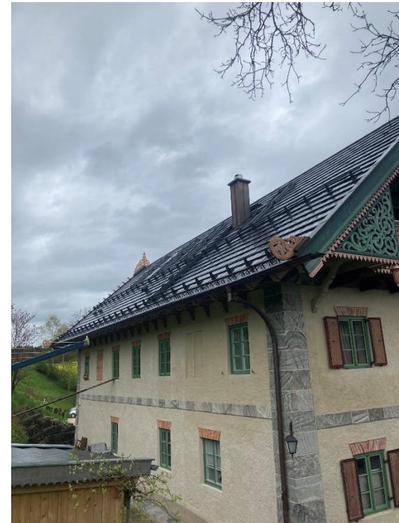
Bad Endorf (Lkr. Rosenheim), Solarziegel, kein Denkmal
