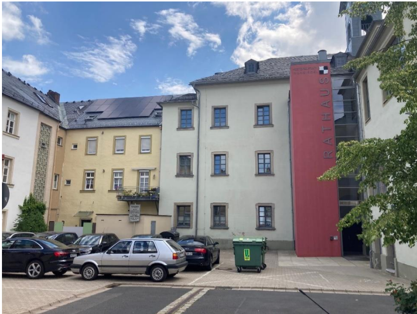
Wunsiedel, rückwärtige Hofansicht, Denkmal
