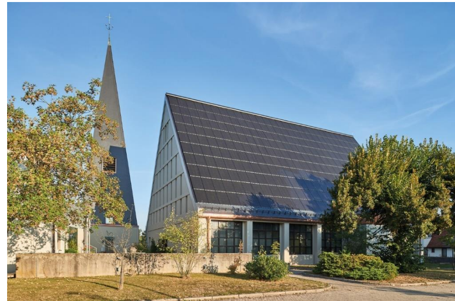
Georgensmünd (Landkreis Roth), Solaranlage, kein Denkmal
