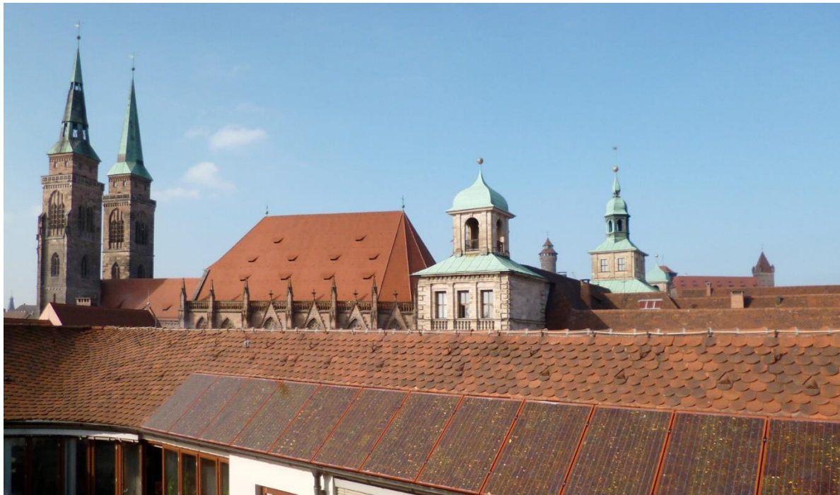
Nürnberg Neues Rathaus, Denkmal
