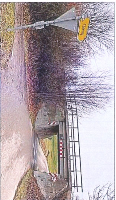
Die Eisenbahnüberführung Mitterteich soll abgebrochen und ein Ersatzbauwerk etwas weiter westlich errichtet werden.
