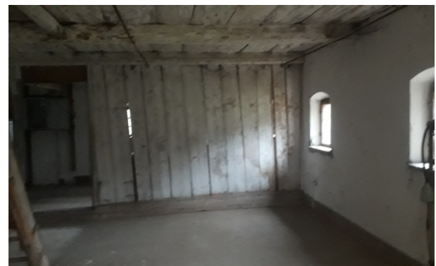
Gemauerter Gebäudeteil im 1. Stock
