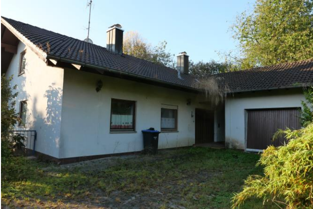
Abbildung 19: Rolladenkästen an der Westseite des Nebengebäudes.
