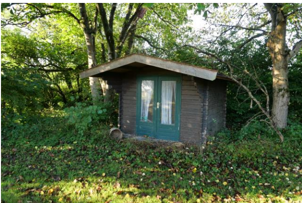
Abbildung 23: Vergitterte Lüftungsöffnungen ermöglichen keinen Einflug von Fledermäusen ins Gebäudeinnere.
