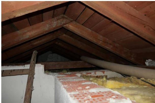
Abbildung 27: Ausschnitt Dachboden Hauptgebäude.
