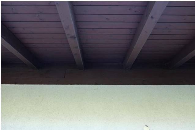
Abbildung 21: Potenzielles Fledermausquartier bieten die Spalten und Mauerausbrüche im Dachbereich.
