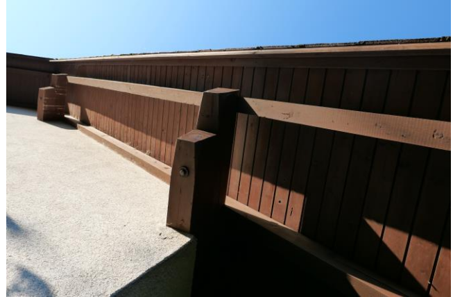
Abbildung 20: Beispiel Rolladenkasten, Hauptgebäude.
