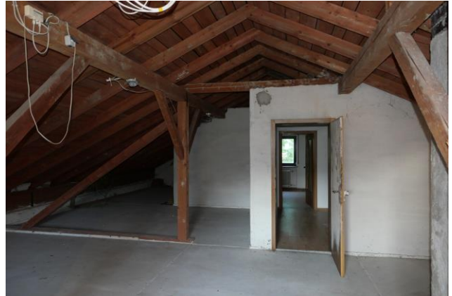
Abbildung 26: Vergitterte Lüftungsöffnungen bieten keine Einflugmöglichkeit ins Gebäudeinnere.
